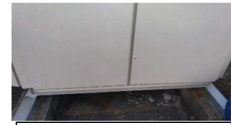
西扉下部補修後
