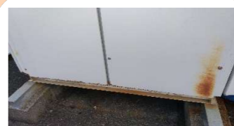
西扉下部補修前
